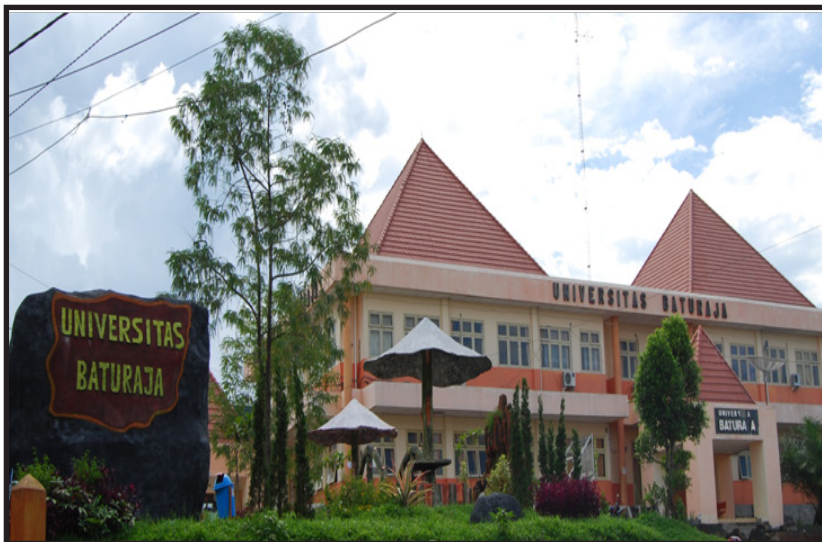
Gedung Rektorat Universitas Baturaja (Foto, dok Tim)
