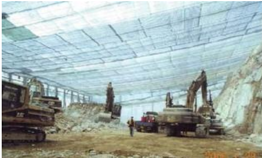
Gambar 2.7. Pemasangan Roofover
