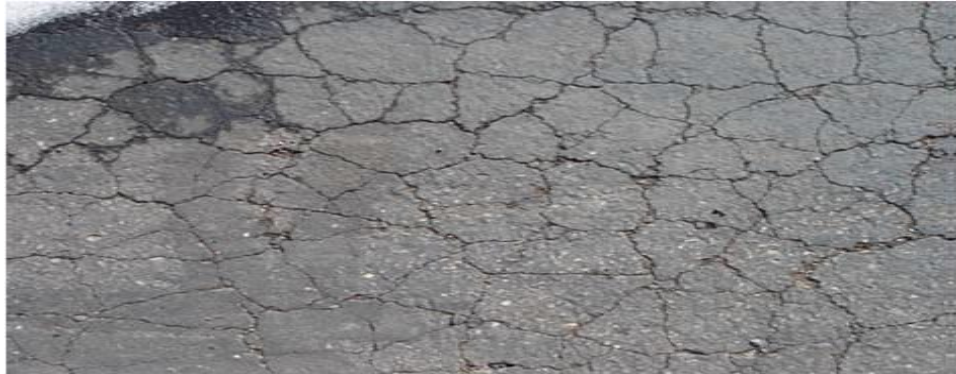
Gambar 3.4 Retak Halus (Mulki, 2018)
