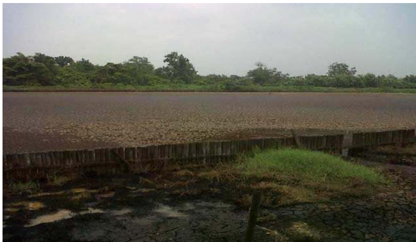
Gambar 3. Kolam Primery Anaerobik Pond
