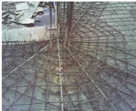
Gambar 2.4 Konstruksi Pondasi Sarang Laba-laba
