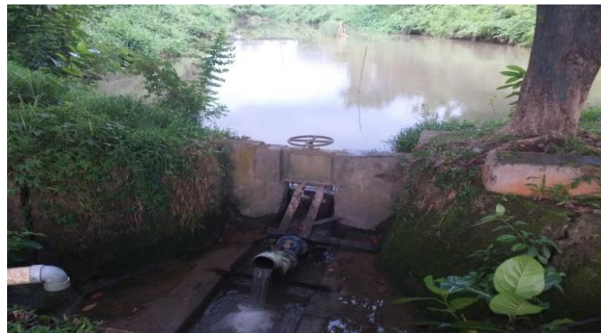
Gambar 6. Pintu Air pada Rawa Buatan 3
