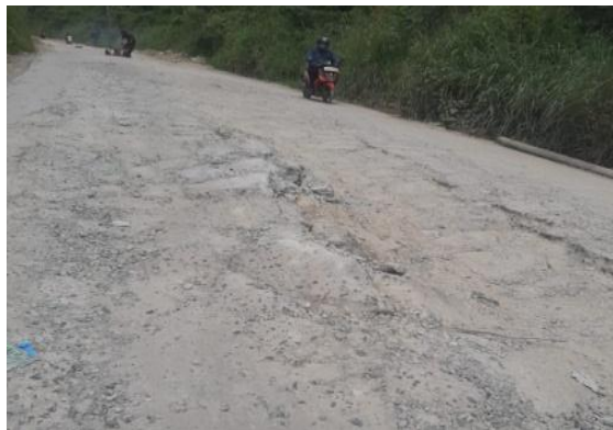
Gambar 2.7 Retak selip ( slippage crack )
