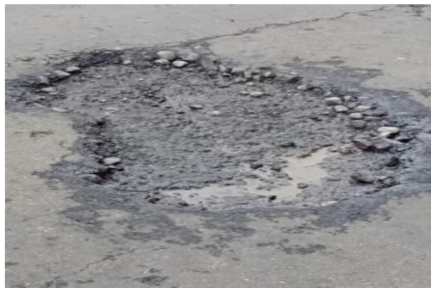
Gambar 2.14 Pelepasan butir ( ravelling )
