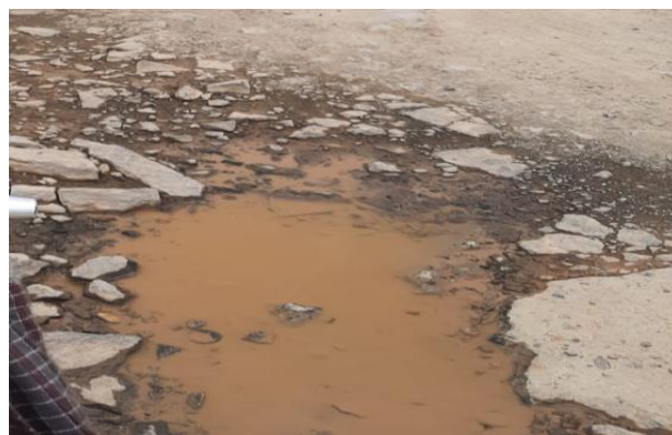
Gambar 2.15 Pengelupasan lapis permukaan ( stripping )
