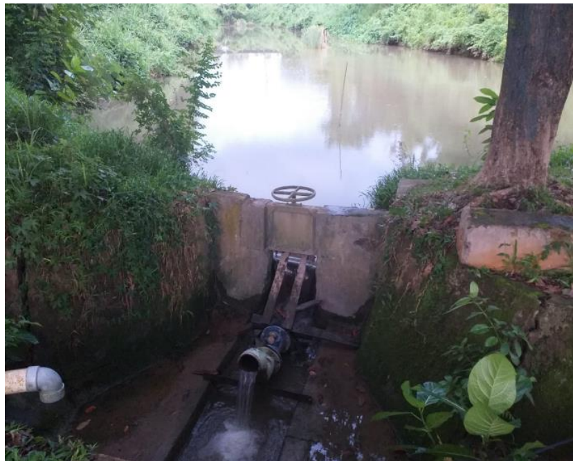
Gambar 2.8. Pintu Air Rawa Buatan 3
