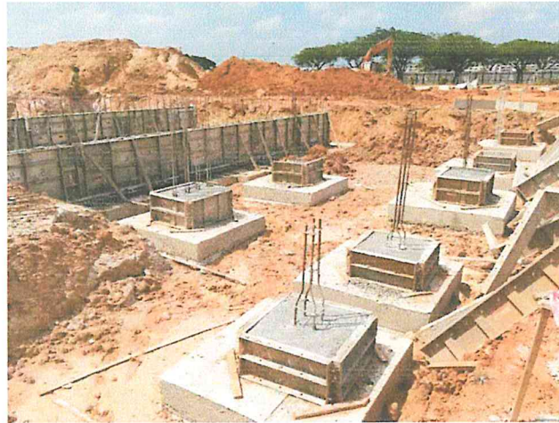
Gambar 2.12 Pile Cap Jembatan
