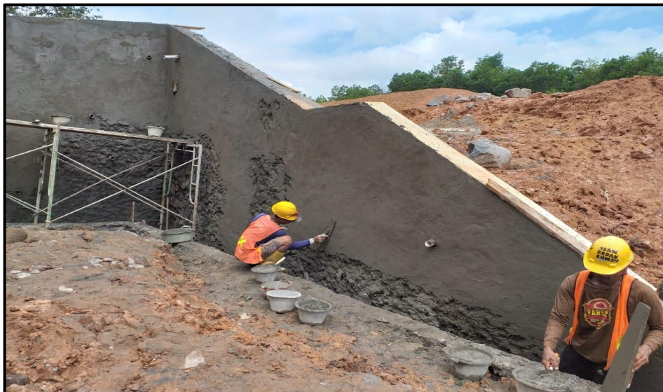
Dokumentasi Retaining Wall pemasangan pipa PVC 2"
