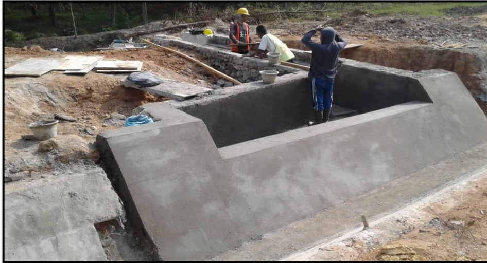
Dokumentasi pemasangan batu, plasteran dan spesi
