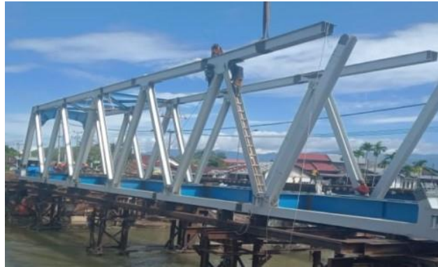
Gambar 2.1 Jembatan Rangka Batang Tipe Warren truss
