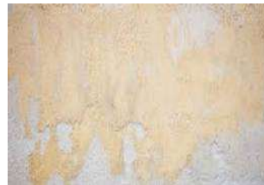
Cat dinding memudar hingga berubah warna
