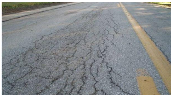
Gambar 2.5.7 Retak Memanjang
