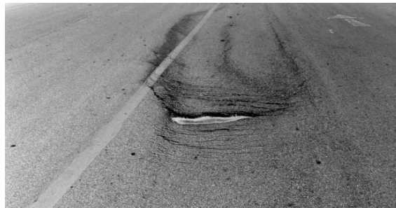
Gambar 2.5.10 Retak Slip
