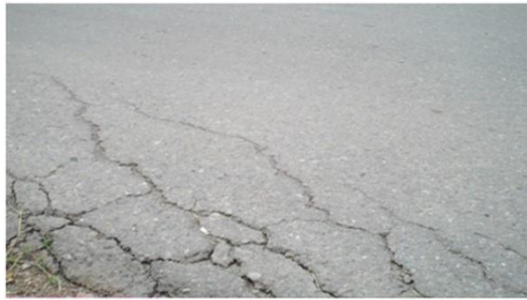
Gambar 2.5.11 Retak Pinggir
