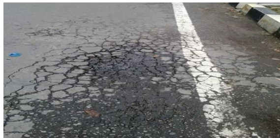
Gambar 2.5.9 Retak Kulit Buaya
