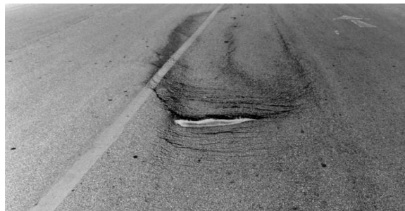
Gambar 2.5.10 Retak Slip
