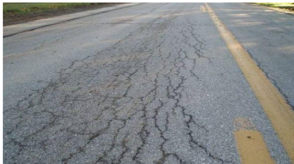
Gambar 2.5.7 Retak Memanjang
