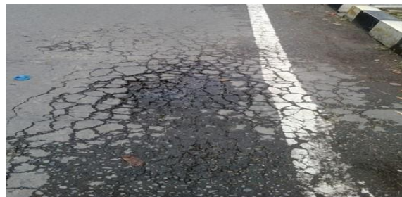
Gambar 2.5.9 Retak Kulit Buaya
