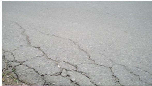
Gambar 2.5.11 Retak Pinggir
