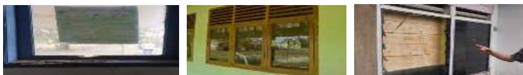
Gambar 2.3.3 Daun Jendela keropos, terjadi keretakan pada kaca dan kaca pecah
