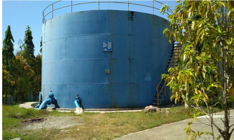
Gambar : 2.10 Reservoir dari baja
