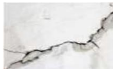
Retakan permukaan dinding lebar retakan kira-kira 0.2mm - 1.0mm)
