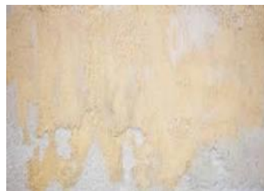
Cat dinding memudar hingga berubah warna
